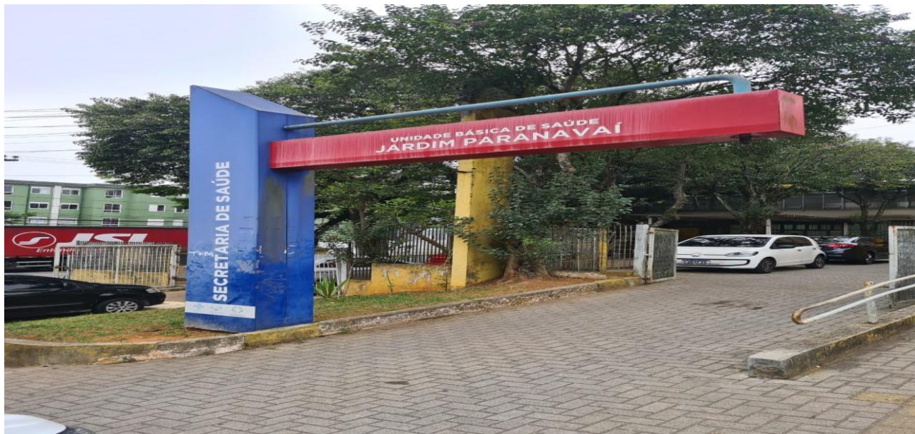
Identificação da fachada – Unidade Básica de Saúde Jardim Paranaíba
