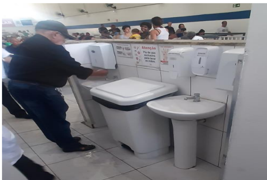
Lavatório da entrada
