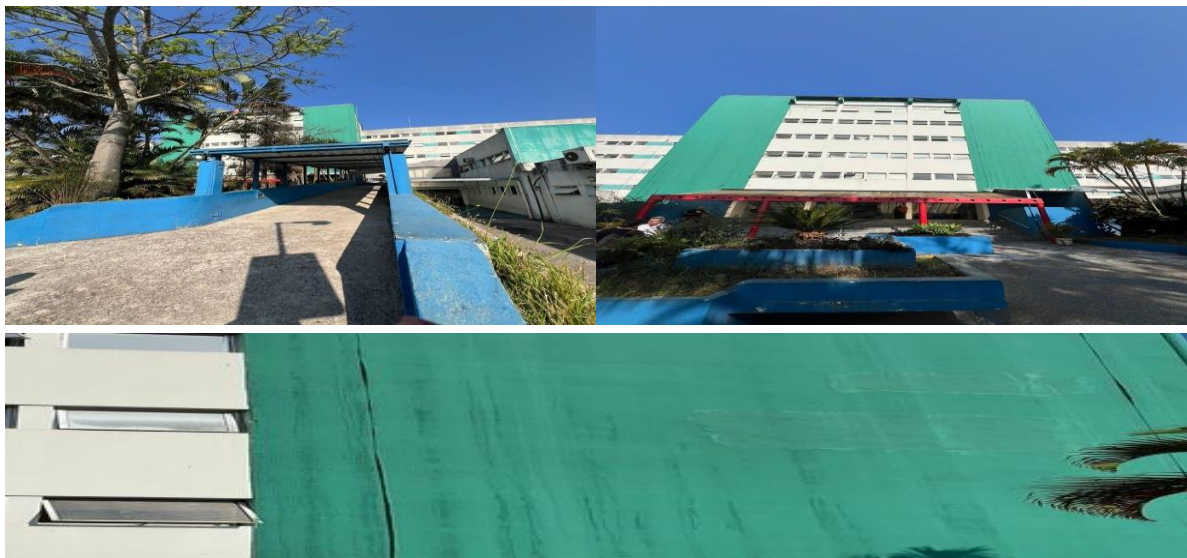
Danos estruturais na fachada da Unidade saneados
