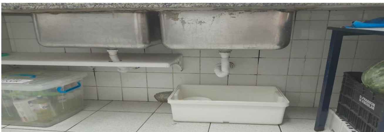
Vazamento no sifão da pia reparado
